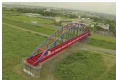
常光浄水場の水管橋
