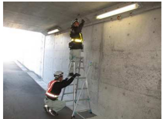
写真 2-7 梯子による近接目視点検
