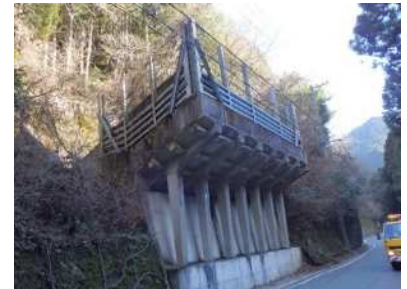
写真 2-3 落石防護柵 (国道 152 号シェッド 1)
