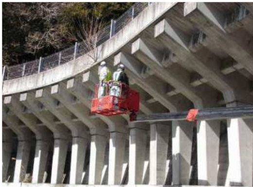
写真 2-6 高所作業車による近接目視点検
