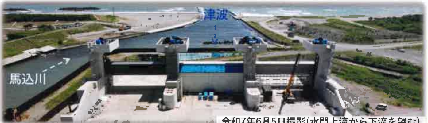
令和7年6月5日撮影(水門上流から下流を望む)
