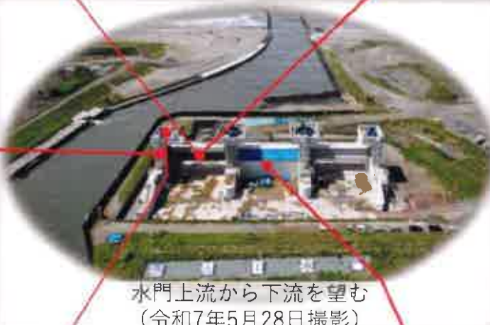
螺旋階段(左)設置完了
