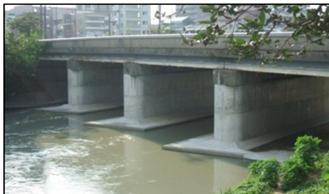
図 橋梁の耐震補強の事例 【基本方針3(1) 緊急輸送路の沿道建物や橋梁の耐震化による道路ネットワーク寸断の防止など】
