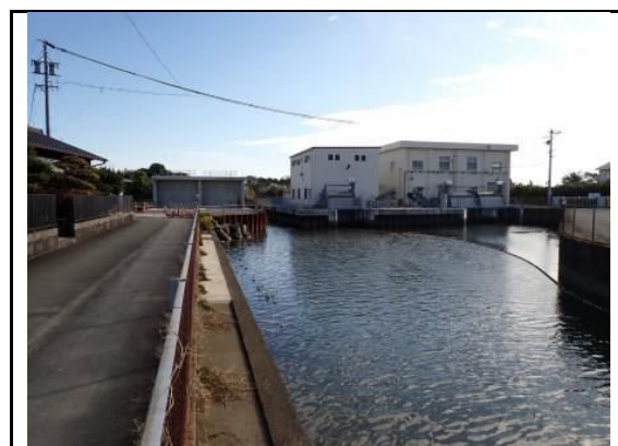
図 排水機場（高塚川）
