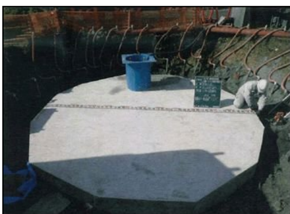
図 耐震性貯水槽
