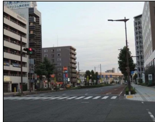
図 無電柱化の整備事例 (市道曳馬中田島線)
