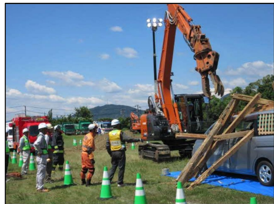
図 道路啓開実働訓練の様子
