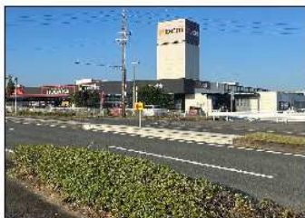
交差点等事故削減対策 【中央分離帯開口部閉鎖】
