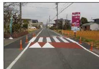
生活道路等安全対策 【ゾーン30プラス(スムーズ横断歩道設置)】
