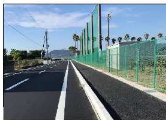
通学路安全対策 【歩道設置】
