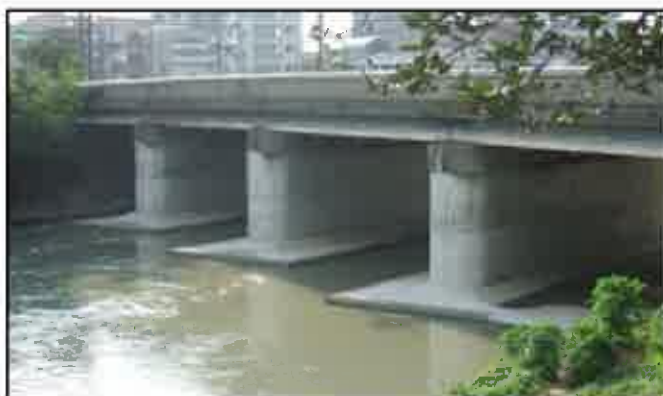
図 橋梁の耐震補強の事例 【基本方針3(1) 緊急輸送路の沿道建物や橋梁の耐震化等による道路ネットワーク寸断の防止等】
