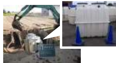
合併処理浄化槽の設置
