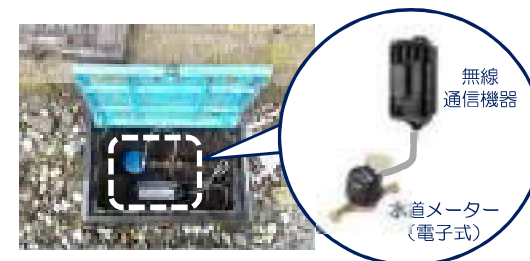
水道スマートメーター設置＜実証実験＞ （令和5～6年度）
