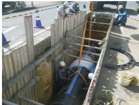
基幹管路耐震化工事（φ900mm）
