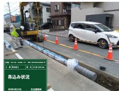
老朽管更新工事（φ150mm）
